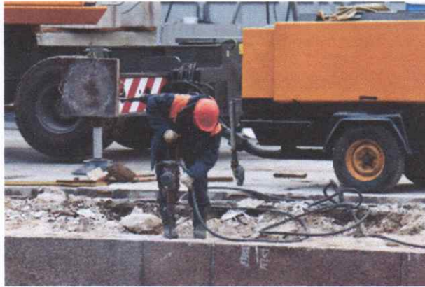
Obras e construções.
